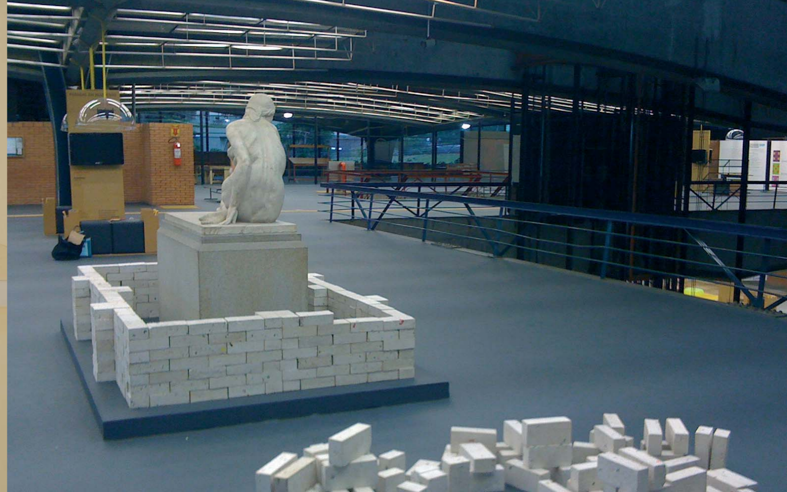
MONTAGEM DA INSTALAÇÃO DO CENTRO CULTURAL SÃO PAULO
